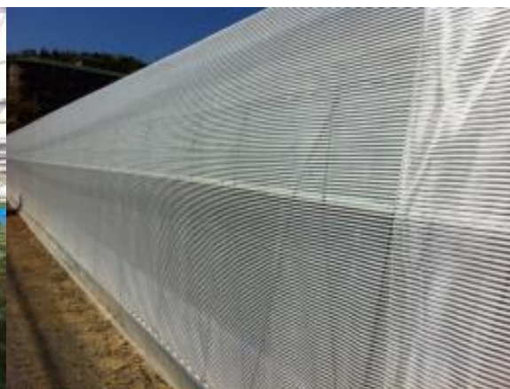
写真 8. ハウスサイドに設置したスリムホワイト 30
