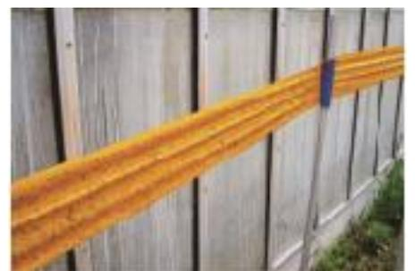
2～3m間隔で直管パイプをたて、高さ1～1.5m、壁面から30～50cmの位置に設置してください。
