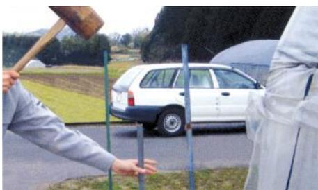
ハウス用の直管パイプを1～2mに切り、1.5～2m間隔に打ち込みます。
