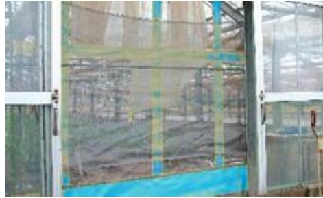
出入り口のネットに直接貼って飛来した害虫を捕まえます。
